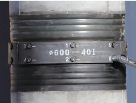
本締め完了後、ボルト頭部とプレートのマーキング のズレを確認する。
