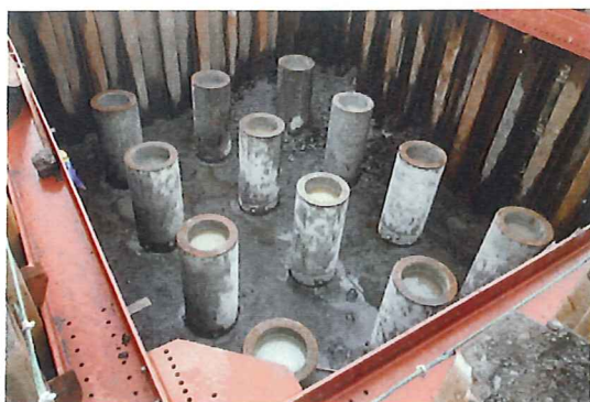
施工後の杭頭部掘削状況
